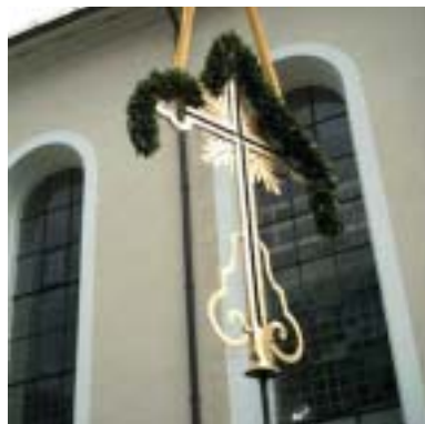
Das neu restaurierte Kreuz unterwegs auf den Kirchturm
