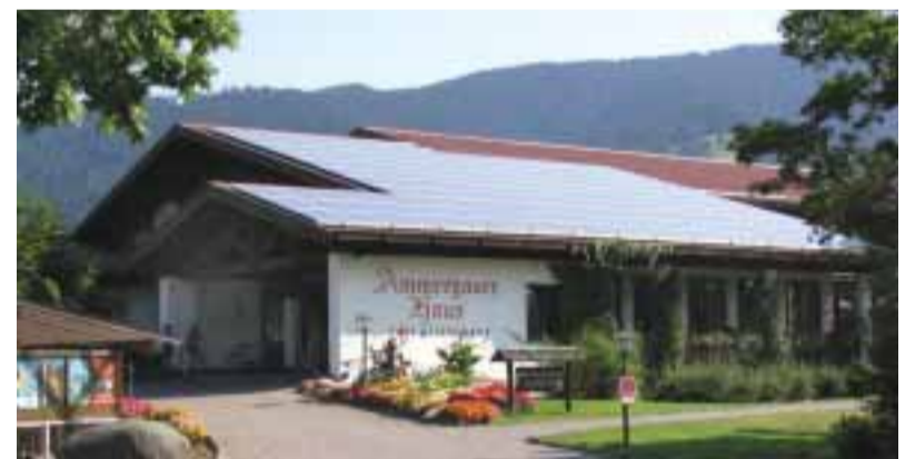
Photovoltaik Anlage auf dem Ammergauer Haus
