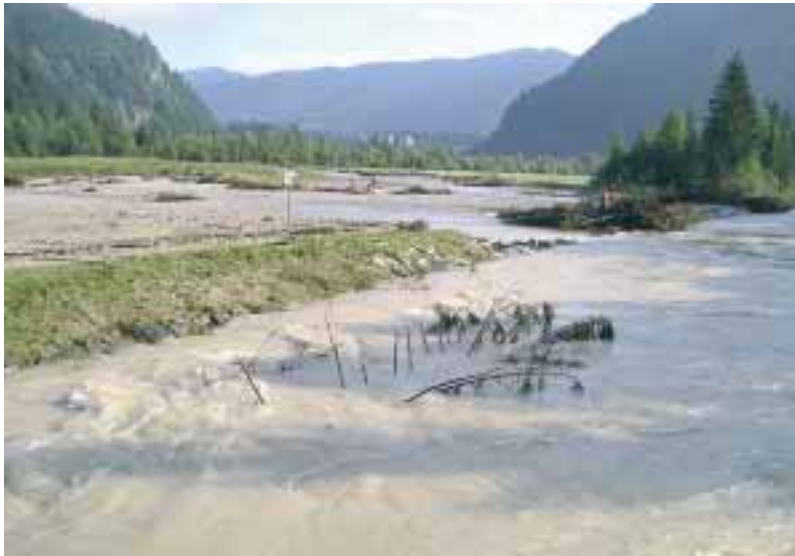
Das untere Weitmoos nach dem planmäßigen Dammbruch im August 2005.
